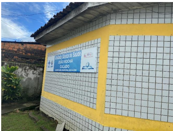
Figura 1: Trocar revestimento externo.
