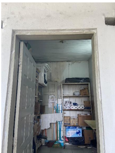
Figura 11: Substituição de esquadrias
