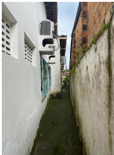
Figura 8: Pintura de muro.
