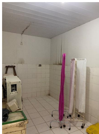
Figura 16: Aplicação de pintura e troca de revestimento.
