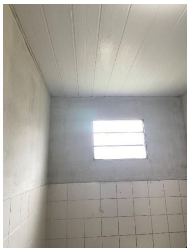
Figura 1: Aplicar pintura e revestimento novo.
