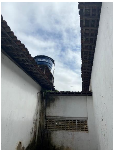
Figura 13: Revisão de cobertura e pintura externa.
