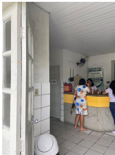
Figura 2: Trocar revestimento e revisar forro pvc.
