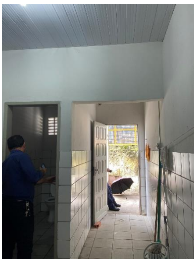
Figura 9: Troca de revestimento e substituição de esquadria.
