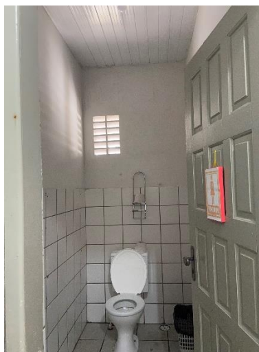
Figura 10: Troca de louças e de revestimento cerâmico.
