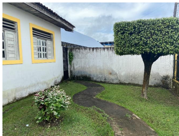
Figura 18: Aplicação de revestimento externo.
