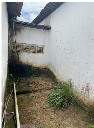
Figura 12: Executar pintura externa.
