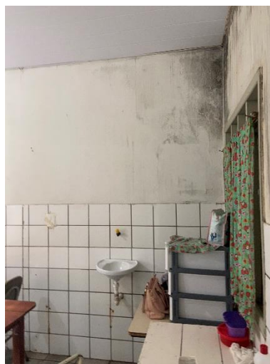
Figura 6: Remover infiltração, aplicar revestimento e pintura.
