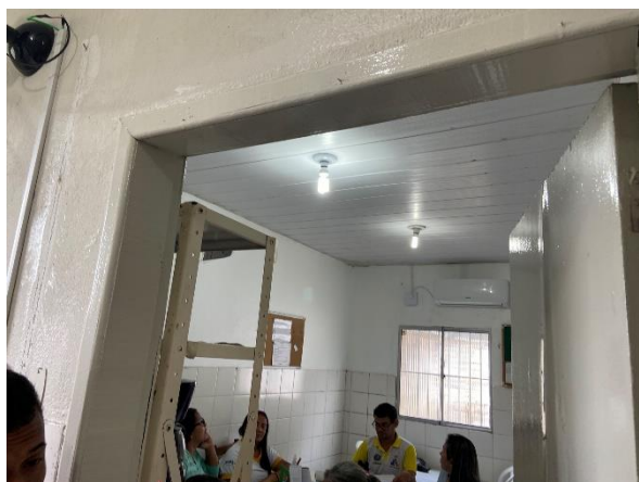
Figura 17: Troca de luminárias.
