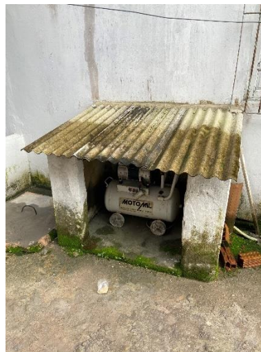
Figura 14: Executar pintura e aplicação de grade.
