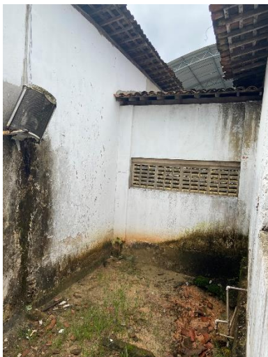
Figura 7: Revisão de cobertura e pintura externa.
