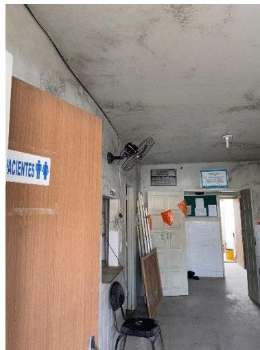
Figura 2: Revisão de telhado e aplicação de pintura.
