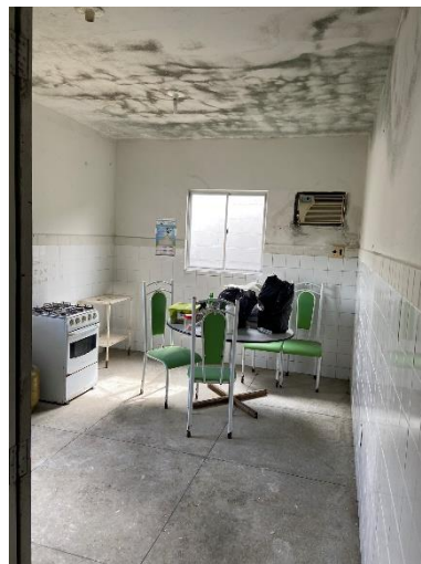
Figura 10: Substituição de revestimento e pintura.
