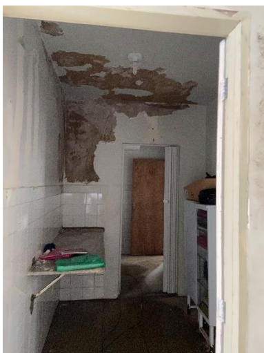
Figura 1: Troca de esquadrias e execução de pintura e revestimento.
