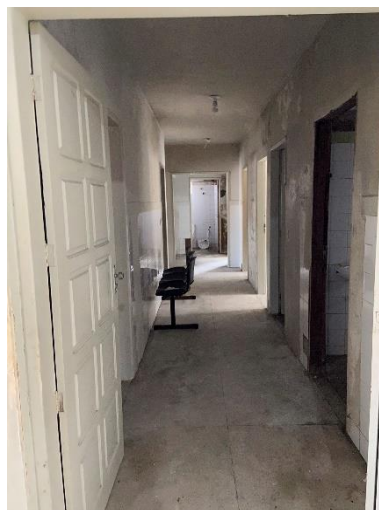
Figura 6: Polimento de piso e substituição de luminárias.
