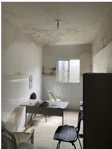
Figura 11: Substituição de pintura e revestimento.
