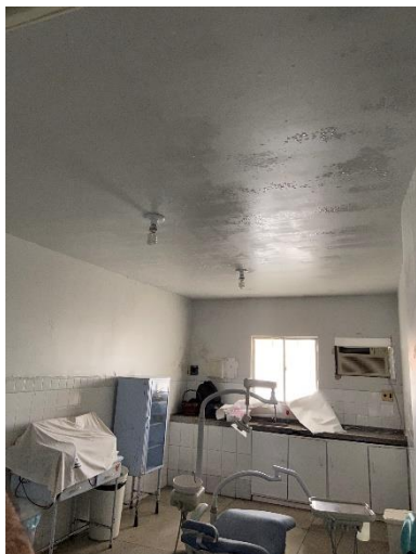
Figura 7: Troca de luminária e aplicação de gradil e película.
