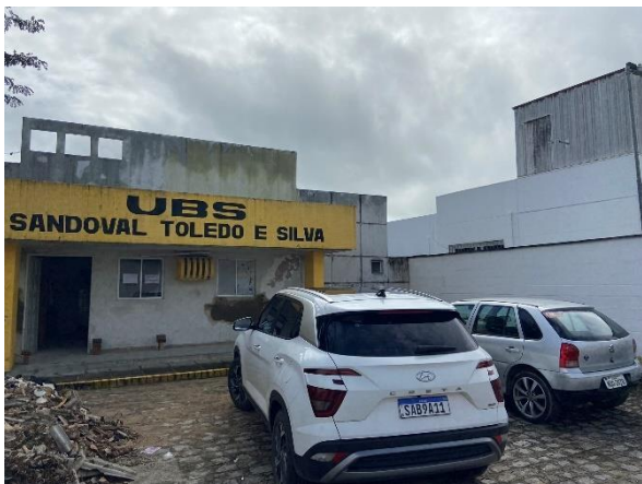
Figura 1: Aplicação de pintura e revestimento externo.
