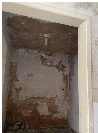
Figura 4: Aplicação de pintura.
