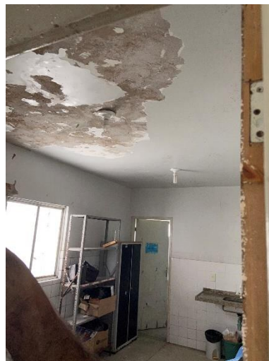
Figura 8: Troca de revestimento e aplicação de pintura.
