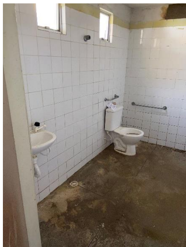
Figura 5: Executar revestimento e troca de louças.
