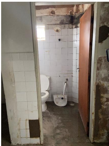
Figura 9: Substituição de louças, esquadrias e revestimento.
