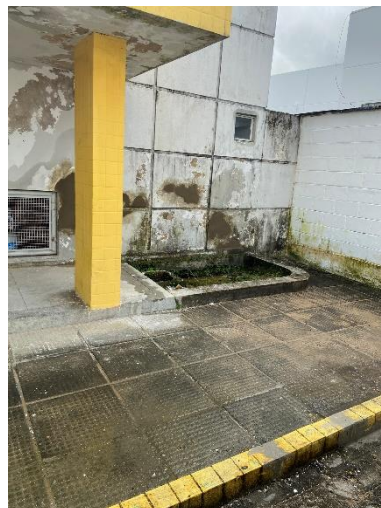
Figura 12: Executar pintura e revestimento externo.
