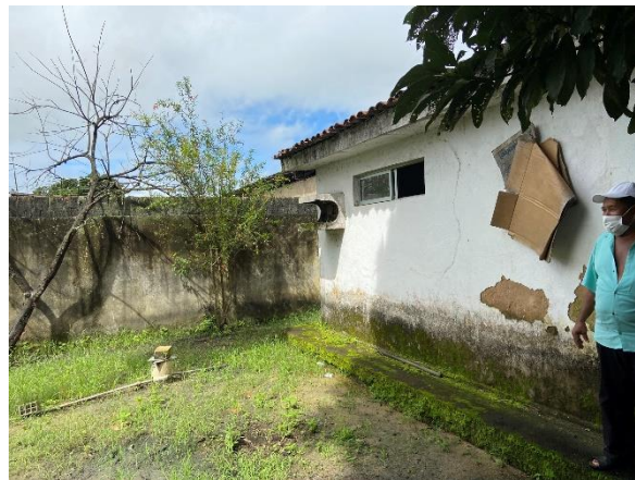
Figura 10: Substituição de esquadrias danificadas.
