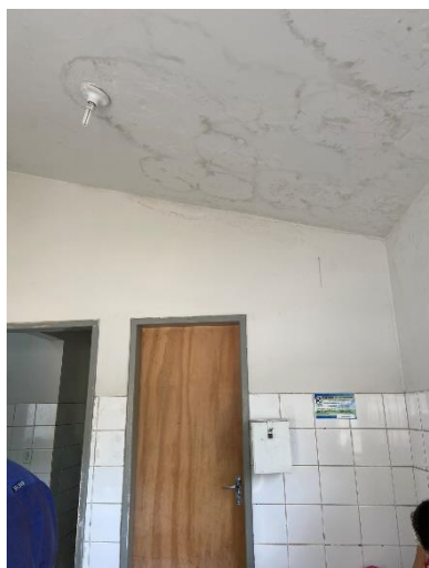
Figura 1: Revisar coberta e aplicar de pintura.
