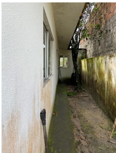
Figura 5: Aplicação de gradil e película em janelas.
