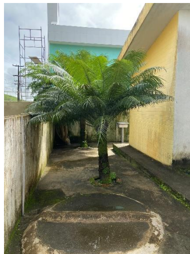
Figura 2: Pintura externa e execução de piso em concreto.
