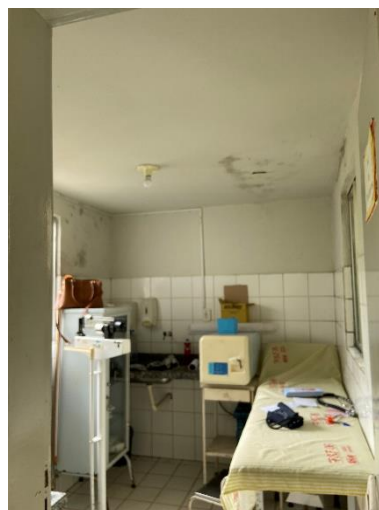
Figura 6: Substituir revestimento e aplicar pintura.
